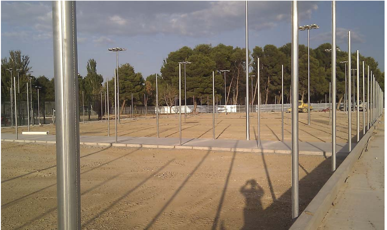
PISTAS DE TENIS: PREPARACIÓN DE INSTALACIONES Y EQUIPAMIENTO
