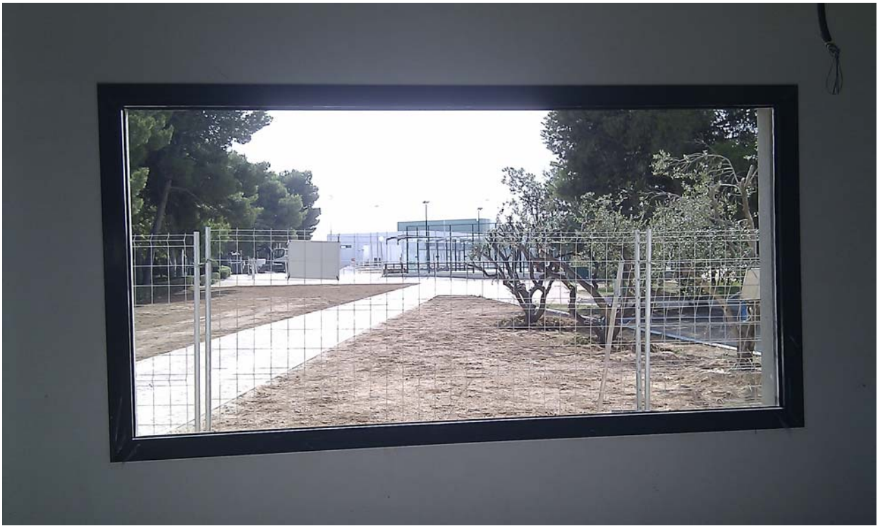
RINCON DE LA AMISTAD: CARPINTERÍA, URBANIZACION EXTERIOR
