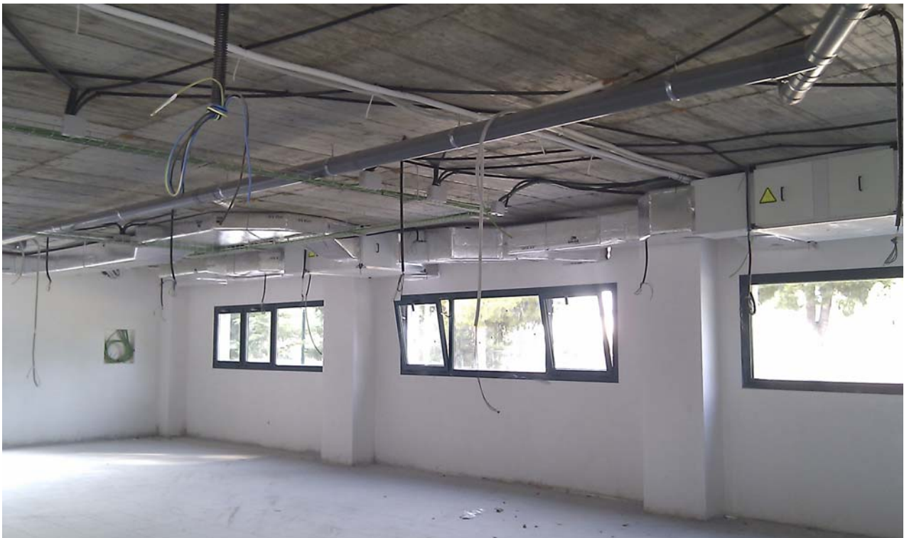
RINCON DE LA AMISTAD: CARPINTERÍA, PAVIMENTO, INSTALACIONES EN TECHO
