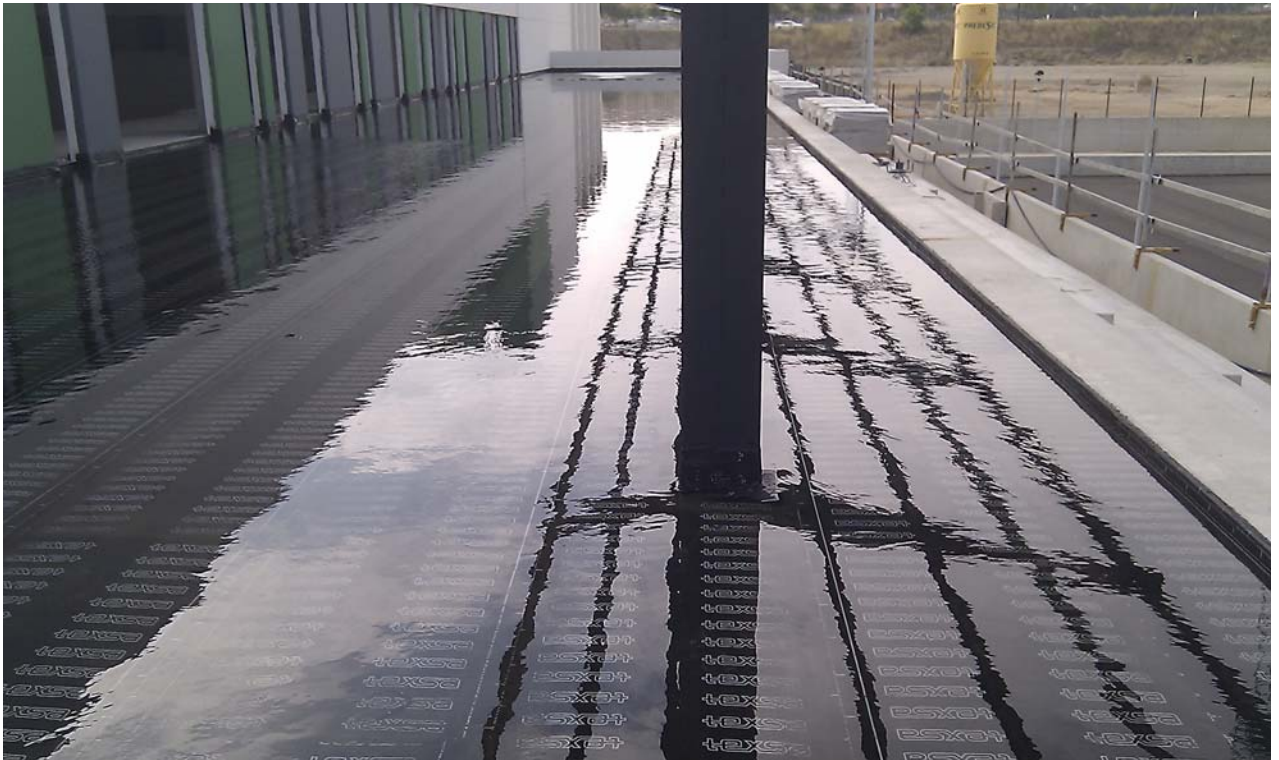
PABELLON POLIDEPORTIVO, TERRAZA DE PLANTA 1ª: REALIZADA PRUEBA DE IMPERMEABILIZACION
